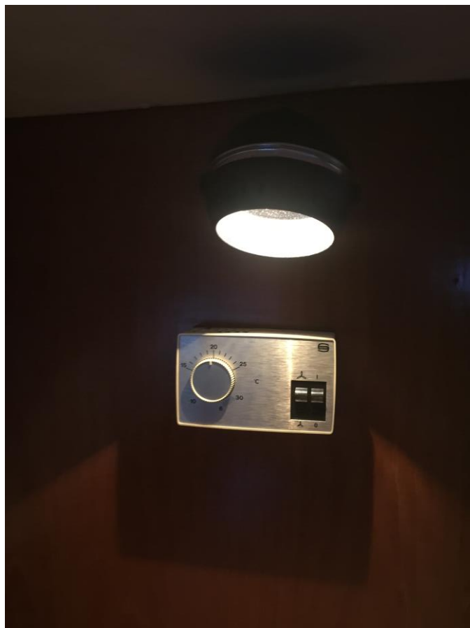
Eberspächer D3L Dieselvärmare. Servad av Värmeteknik i Nykvarn.
